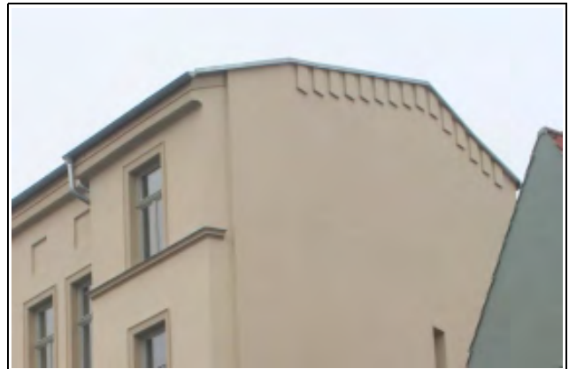
Abb. 34: Vorgefertigte Fledermauskästen an der Außenfassade - Optisch an den Gebäudetyp angepasst 4
