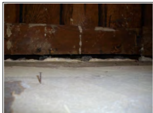
Abb. 15: Spaltenquartier zwischen Dachbalken und Mauer im Dachboden (Ruhlaer Str. 19, Eberswalde) 6
