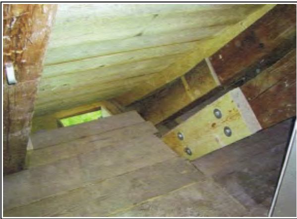
Abb. 20: Lüftungsöffnung und Fledermauseinflug zwischen Dachkante und Mauer 8
