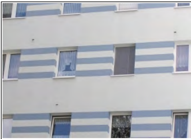
Abb. 49: Integrierte Fledermauskästen an Plattenneubauten (nur längliche Öffnungen sind zu sehen) 4
