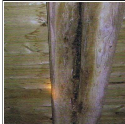
Abb. 22: Spalten schaffen zwischen parallelen Balken 8
