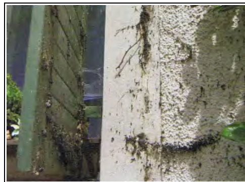
Abb. 30: Fledermausquartier hinter Fensterladen - Im Herbst kann der trockene Kot einfach weggefegt werden. 8
