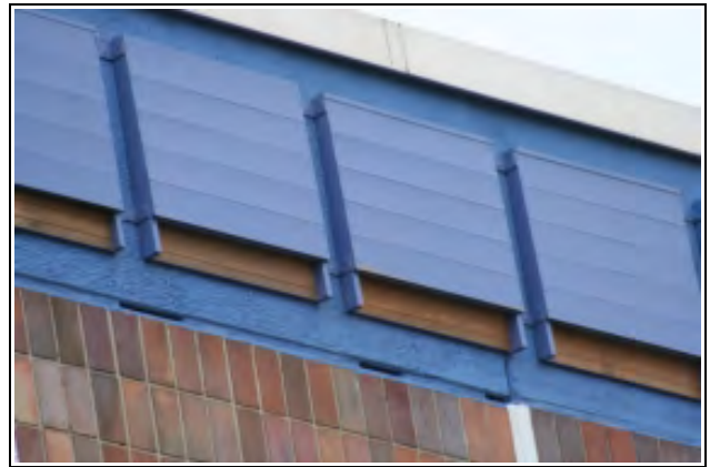
Abb. 54: Fledermaustafeln (ca. 80 x 80 cm) aus faserrauem Holz, innen konisch aufgebaut 4
