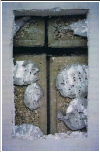
Abb. 52: Kreuzfuge mit aufgeschnittener Dämmung 15
