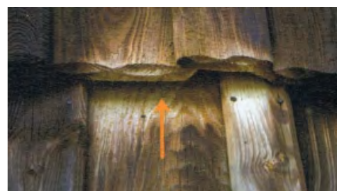
Abb. 11: Durch Urin ausgebleichtes Holz 8
