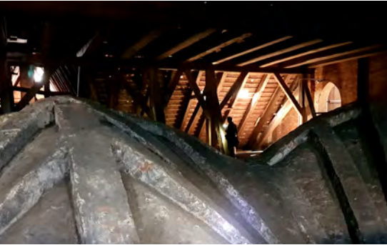
Abb. 3: Dachboden über Kirchengewölbe (Foto: Laura Klein)
